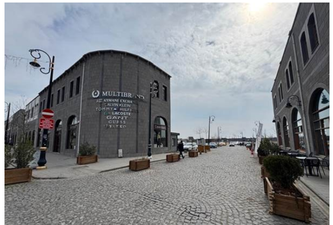
Şekil 3: Yenişehir Caddesi'ndeki genişletme ve betonarme yapılar (28 Şubat 2025).
